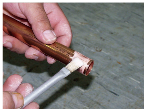
4. Flussmittel am Rohr auftragen
